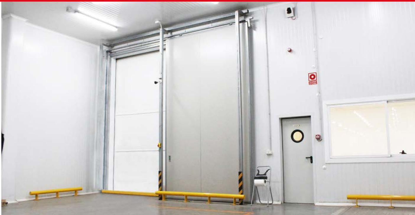
Las puertas correderas cortafuegos Kavidoors poseen una **resistencia al fuego durante 60 minutos**. Suelen permanecer abiertas, retenidas por un electroimán, hasta que, en caso de detección de incendios o un corte en el suministro eléctrico, el sistema de contrapesos provoque el **cierre automático de las puertas**. Estas **sellarán la habitación por completo**. Diseñadas para los sectores de alimentación, distribución y transporte.
