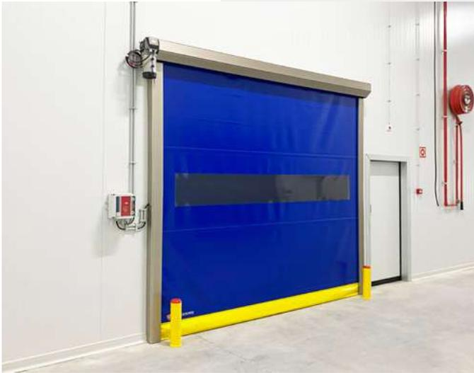
Las puertas rápidas enrollables Kavidoors están especialmente diseñadas para **zonas de interior climatizadas** con temperaturas que oscilen **entre los 5 y los 80 °C**.
